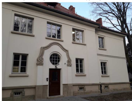
Budynek nr XL (40) Dawne przedszkole w trakcie i po remoncie
